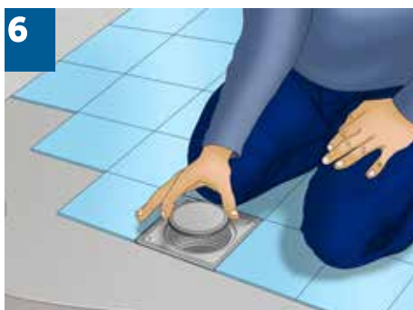
6 Postavljanje privremenog zaštitnog poklopca. Postavljanje pločica na podu kupatila.
