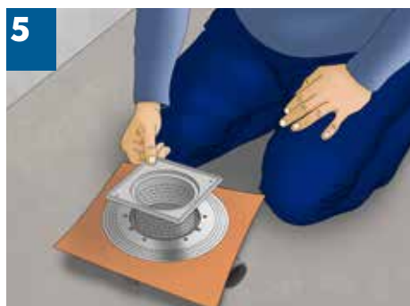
5 Ubacivanje-postavljanje nosača rešetke i njegovo podešavanje po visini i po nagibu.
