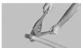
1. Odrežite PEX-a cev pod pravim kotom s PEX-a škarjami ali cevnim prikojevalom.
