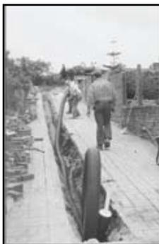
Microflex cevi je možno položiti v tla. Naguban ovoj nudi dovolj zaščite izolacijskega materiala in cevi. Talna voda nima vpliva na Microflex sistem. Cevi je možno položiti v järke direktno iz kolotov. To je možno narediti z vlečenjem nosilnih cevi, izogibajte pa se vlečenju modre ovojne zaščite, ker se s tem zamakne nosilna cev in izolacija in s tem cevi izgubljajo del zaščite.
