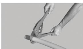
1. Odrežite PEX-a cev pod pravim kotom s PEX-a škarjami ali cevnim prikrojevalom.
