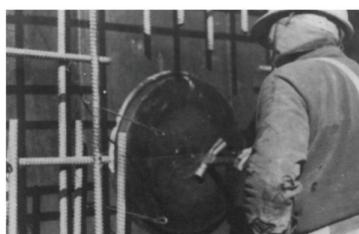
1. »Žebljaste kapek« morajo biti nameščene na vsaki strani luknje, kar omogoča enakomerno zalite z betonom (malto). Zidna spojka za namestitev cevi skozi zid se vstavi v luknjo.
