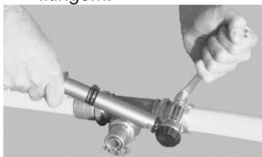
12. Zamenjajte vijak iz nerjavečega jekla in matico in pritrdite zatezni obroč.
